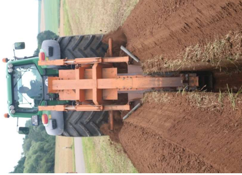
Grabenfräse + Verlegung der Wärmerohre
