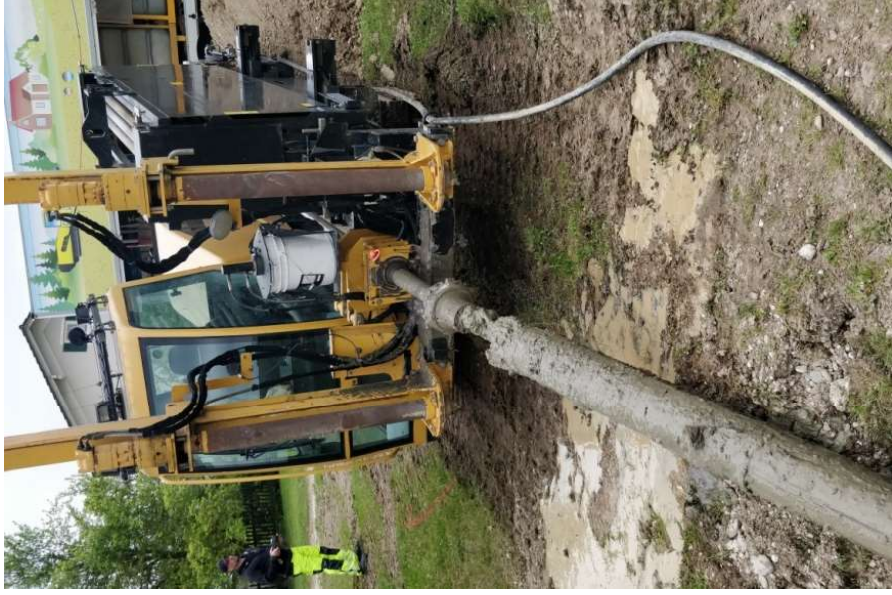
Grabenlose Verlegung im günstigen Spülbohrverfahren
