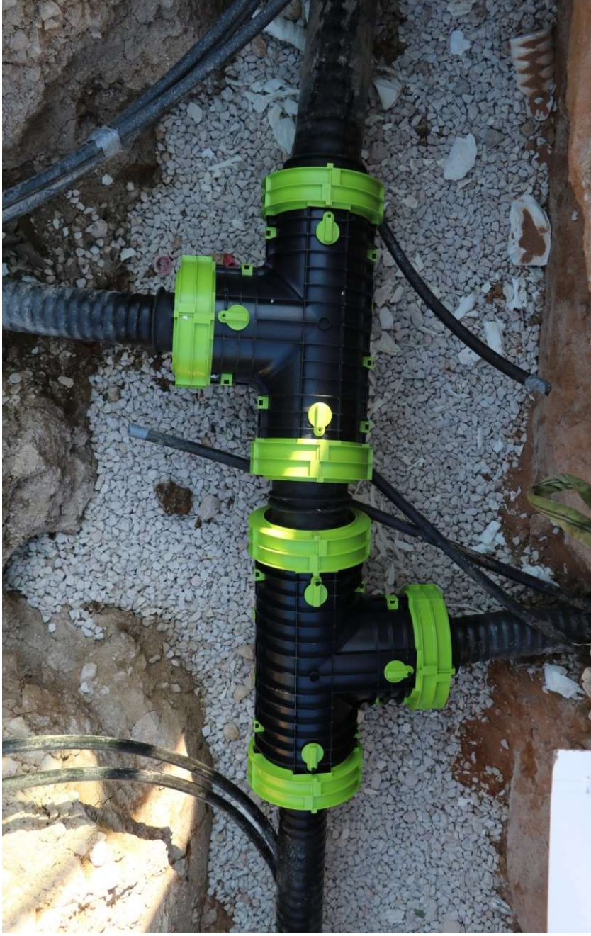
T-Stück im offenen Graben
