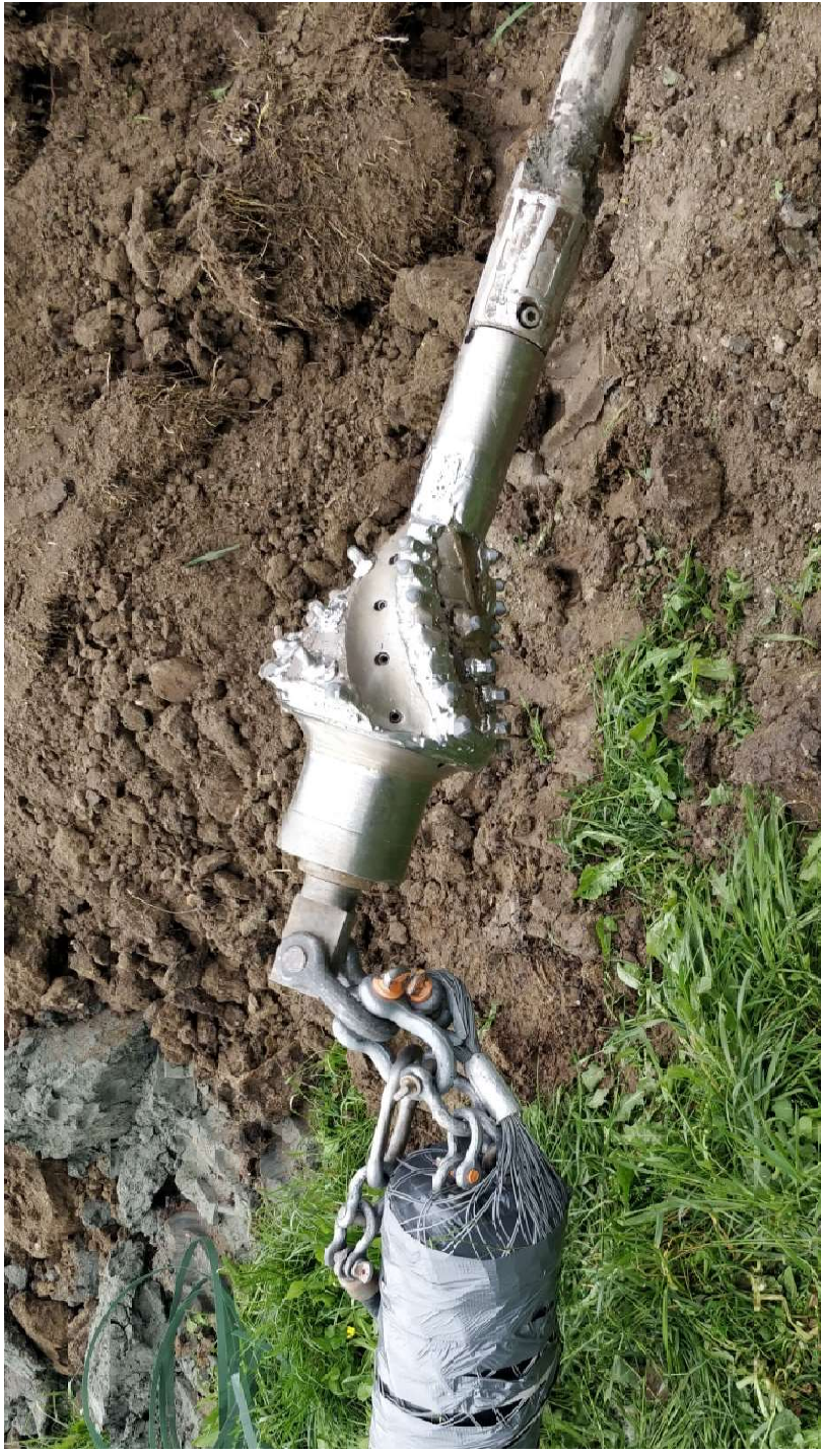
Grabenlose Verlegung im günstigen Spülbohrverfahren
